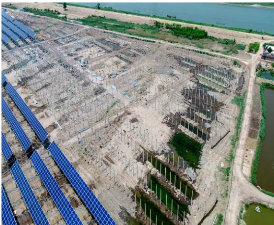
光伏发电工程区桩基础施工
