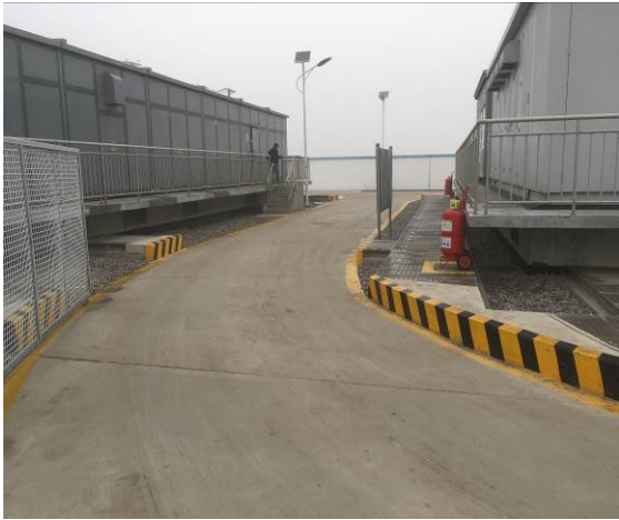
升压站道路硬化
