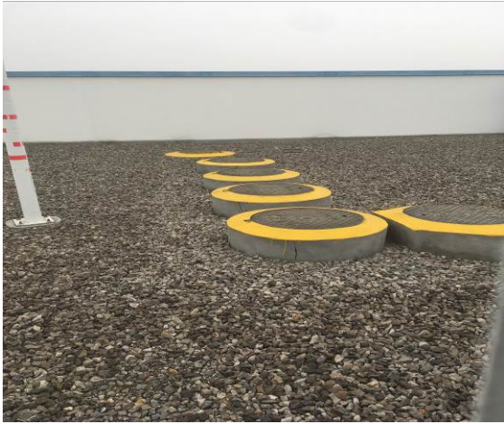
升压站碎石铺盖
