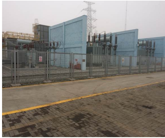
升压站透水砖铺装
